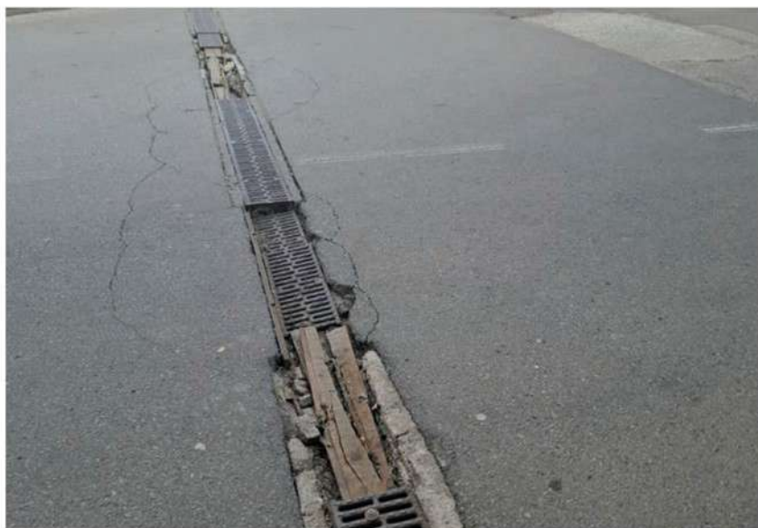
Dotrajana in nevarna kanaleta v Žolgarjevi ulici naj bi bila za težja vozila neustrezna že od izgradnje objekta. Foto: Bralka
